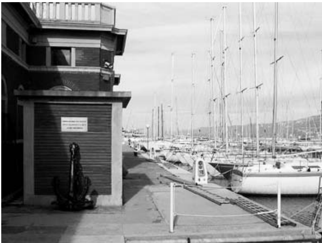
Obr. 2 Výškoměrná stanice na severovýchodní straně mola Sartorio
