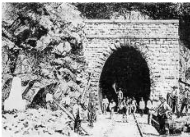
Obr. 8 Vrútocký portál tunela Strečno III so základným výškovým bodom, pred tunelom úrovňový prejazd so závorami (pod pomníkom vyleštená skála so značkou nadmorskej výšky 371,0012 m, n. m., za ňou na ústí tunela zvanom Just hlavná výšková značka s tabuľkou označujúcou nadmorskú výšku).
